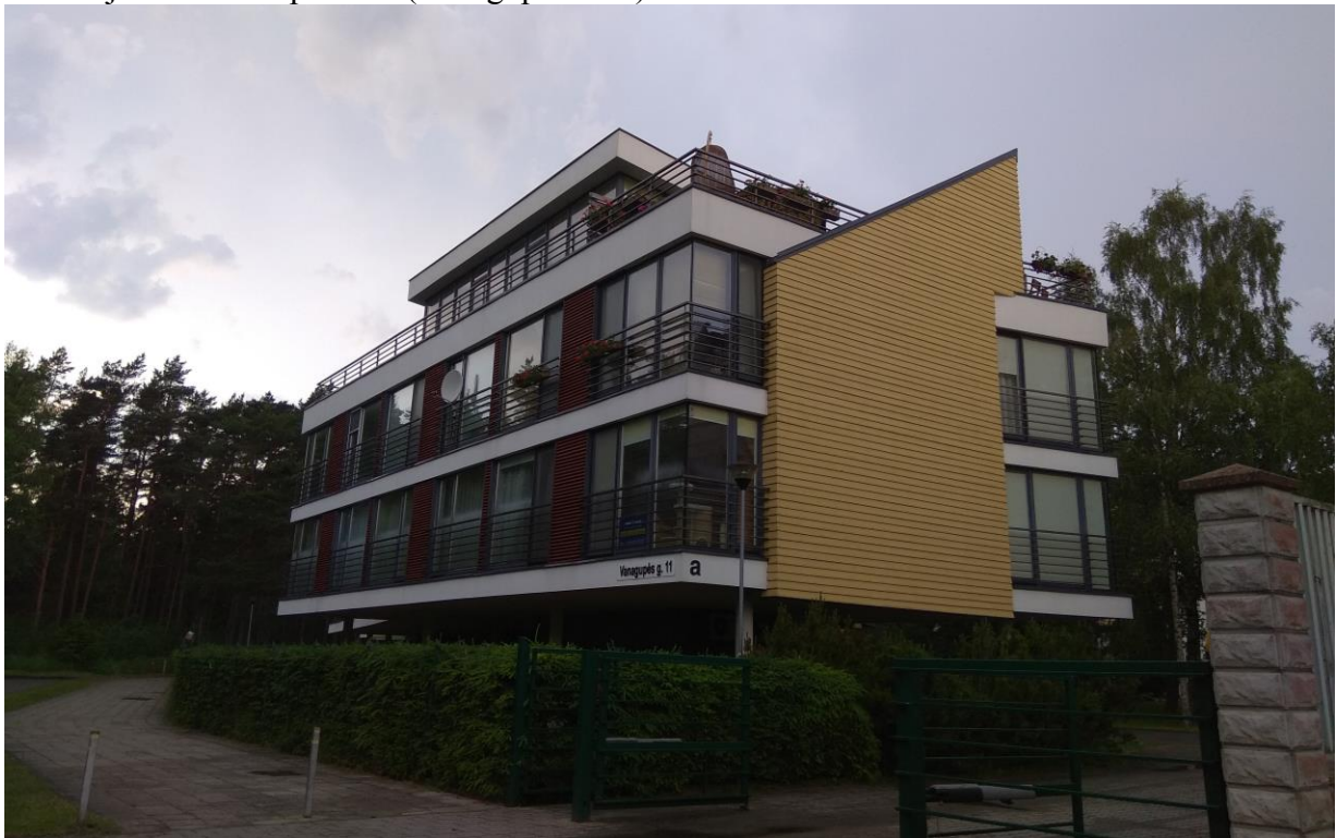
Arčiau jūros esantis pastatai (Vanagupės 11A):
