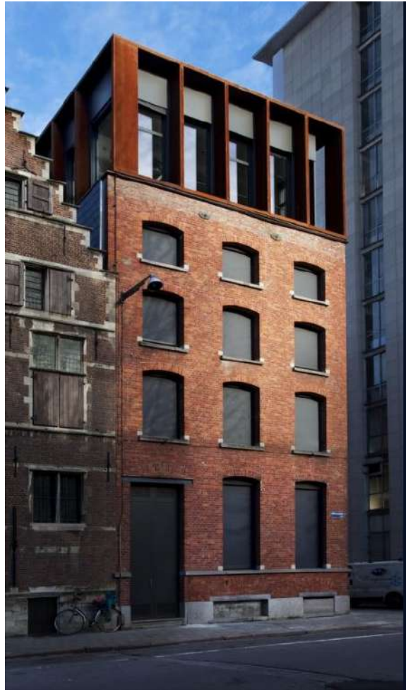
Sandėlio renovacija Atverpene, STRAMIEN
