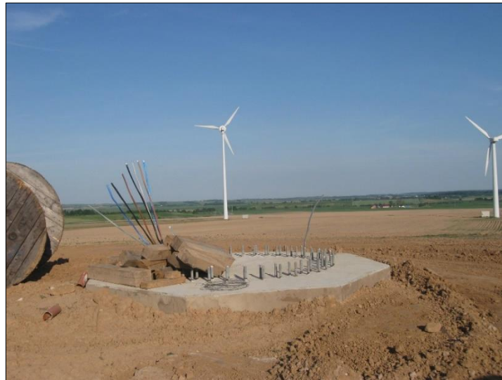
5.4 pav. VJ pamatas, statant plieninį stiebą
