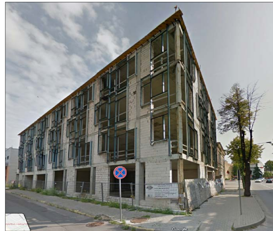
S.Daukanto g.13a, esantis pastatas yra 4 aukštų su mansarda. Jo aukštis metrais yra iki 19m.
