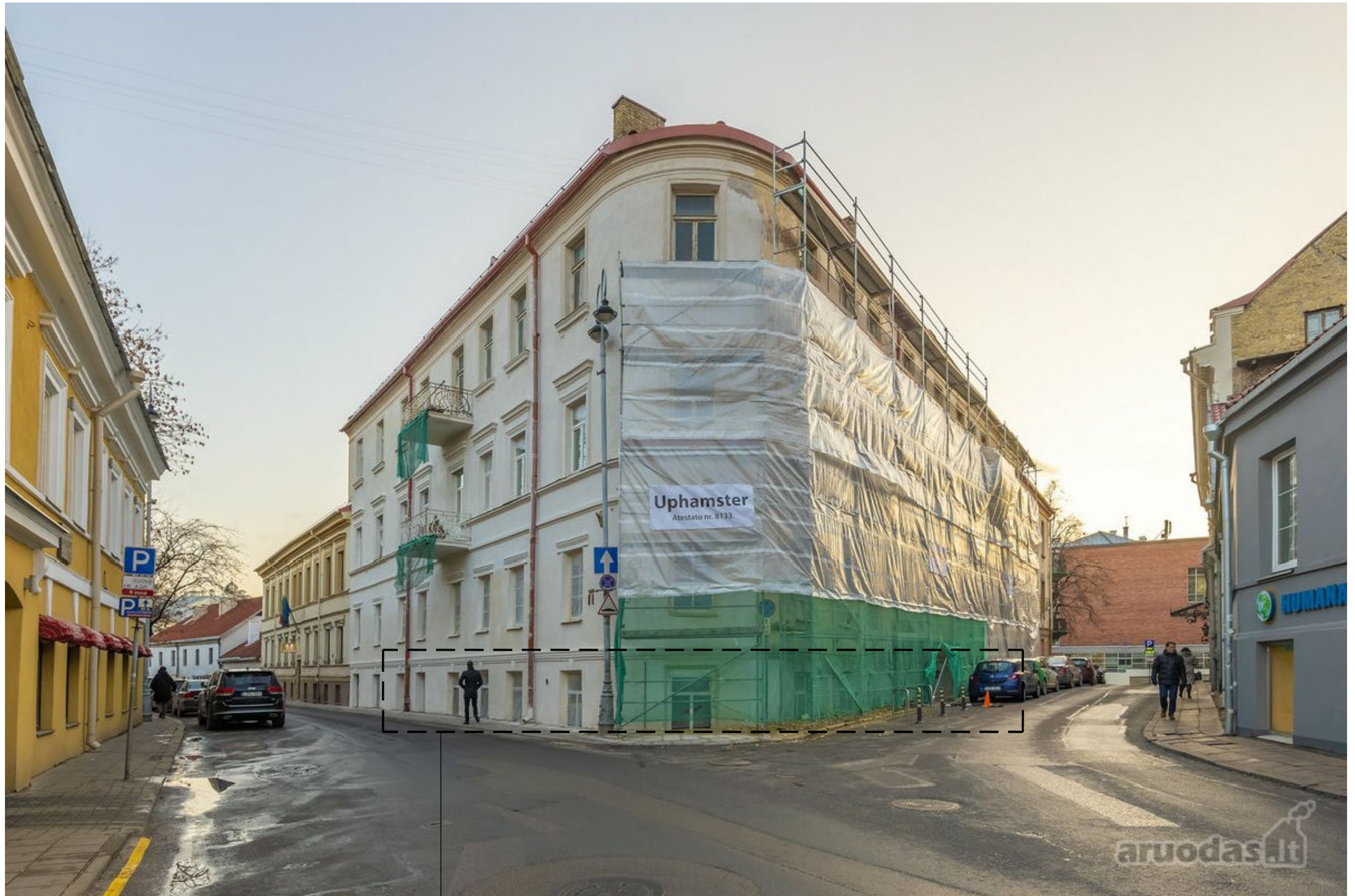
REMONTUOJAMA PASTATO DALIS
