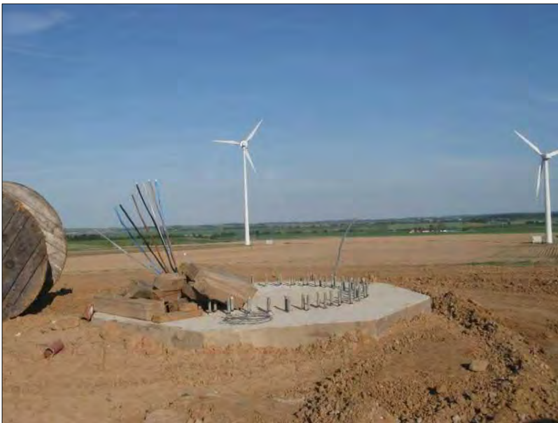
5.4 pav. VJ pamatas, statant plieninį stiebą
