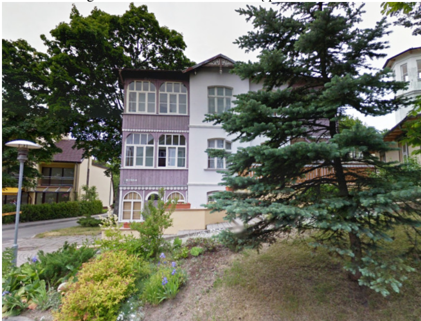
Pastato Kalno g.28 bendras vaizdas iš pietų pusės.
