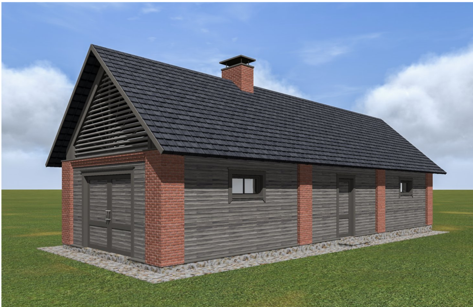
FRONTONO UŽDENGIMAS ŽALIUZE TANKESNIS
