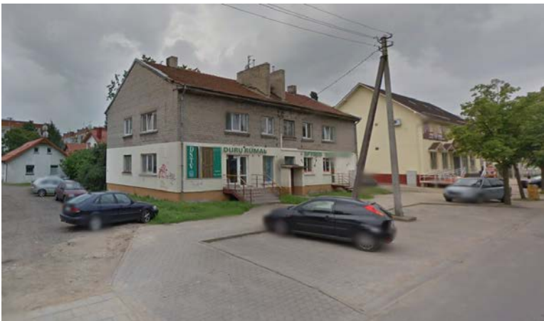
PASTATAS NAIKUPĖS G. 36 SU ESAMOMIS PARDUOTUVĖS PATALPOMIS (pirmame plane)
