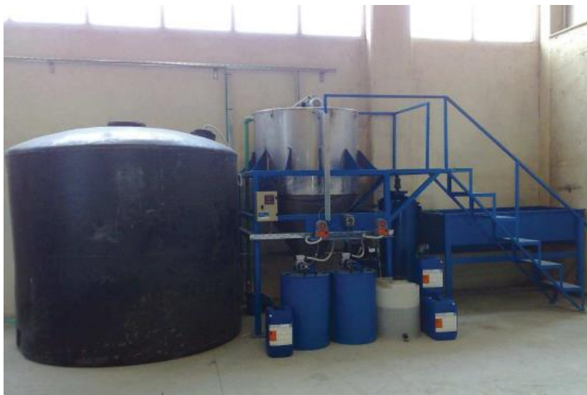
10.1 pav. Planuojami gamybinių nuotekų valymo įrenginių pavyzdys
