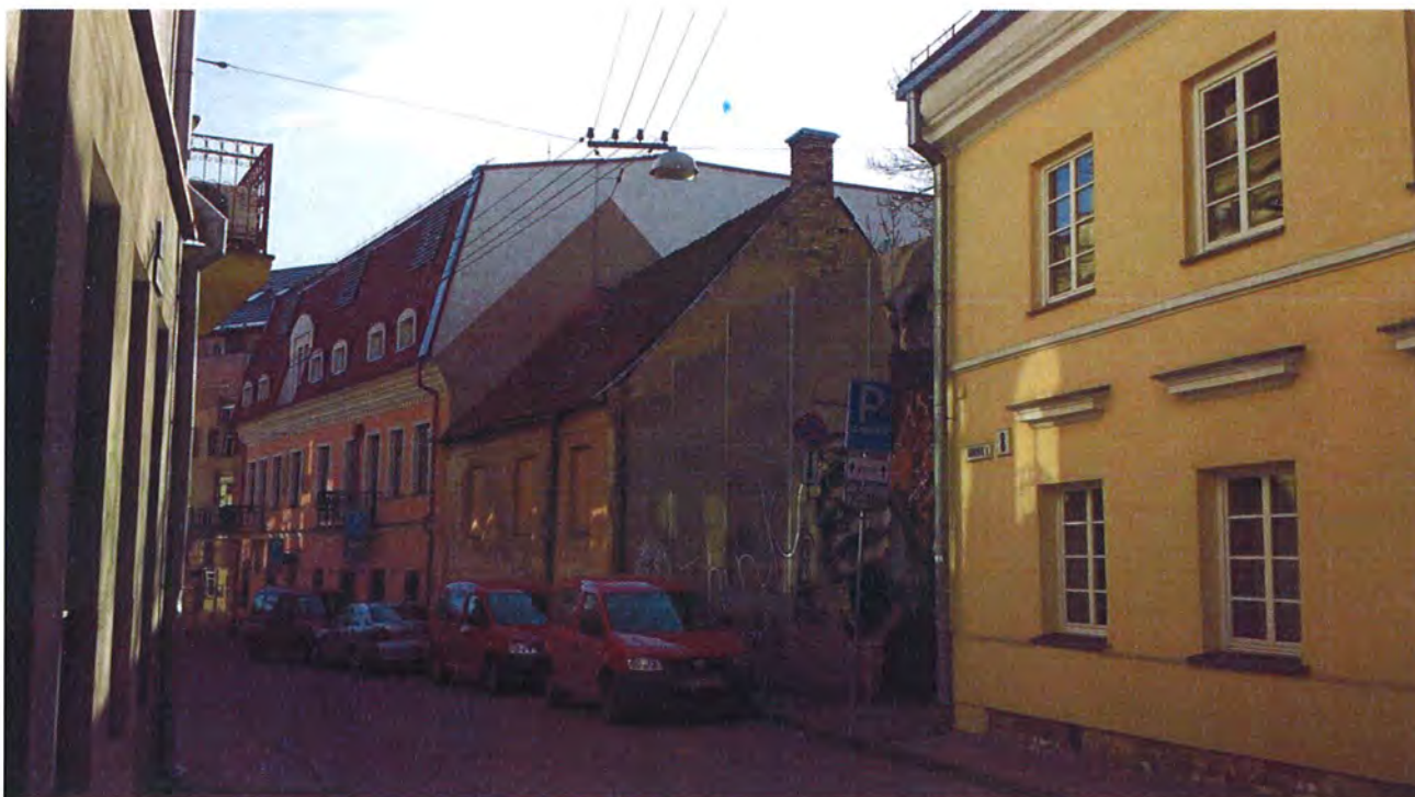
Nuotrauka Nr. 1 – rekonstruojamas pastatas yra rusvos spalvos, matomos užkaltos langų angos. Pastatas ribojasi su kitu statiniu Šiaurės rytų dalimi, Šiaurės vakarų dalis jungiasi su skydu.
