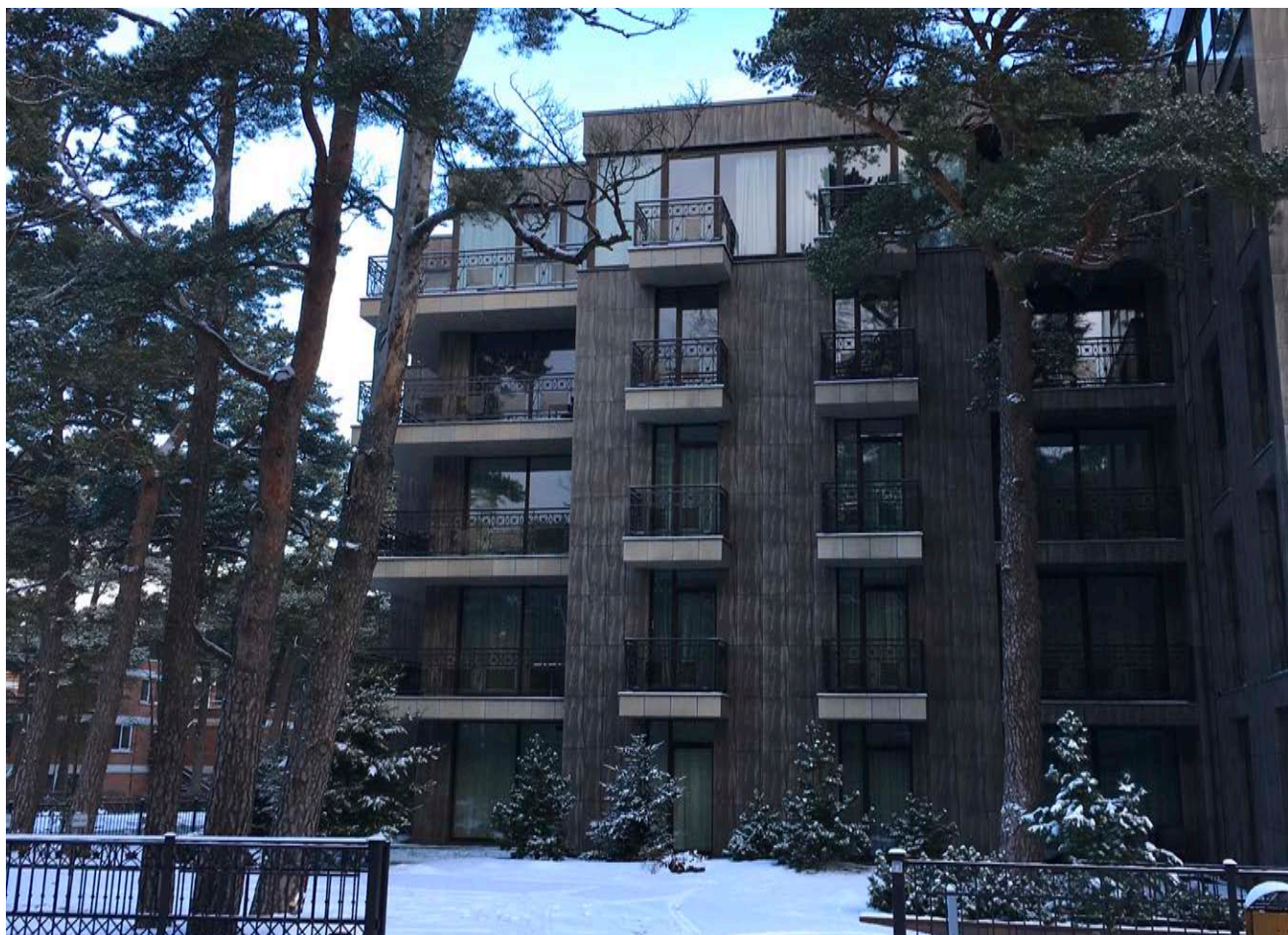
Kęstučio g. 43 (poilsio paskirties pastatas - 27 apartamentai). Pietinis fasadas.
