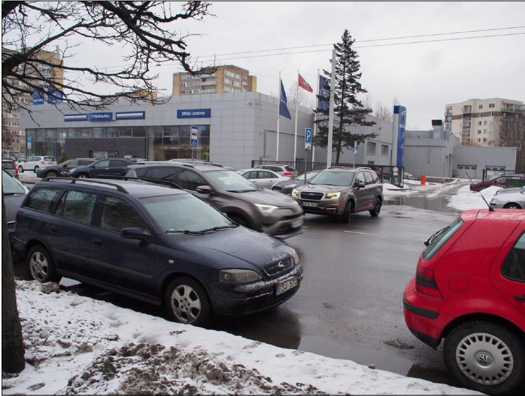
Esamos padėties fotografacija. Vaizdas nuo Verkių gatvės (Vakarinis fasadas)
