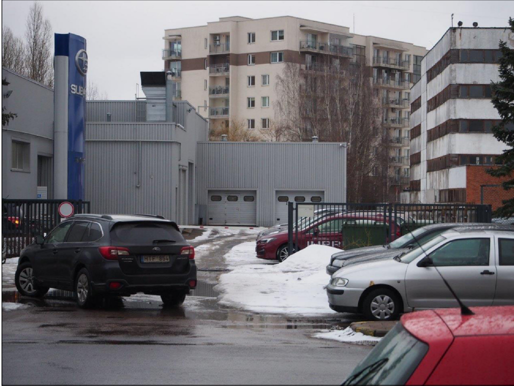
Esamos padėties fotofiksacija. Vaizdas nuo Verkių gatvės (Vakarinis fasadas)
