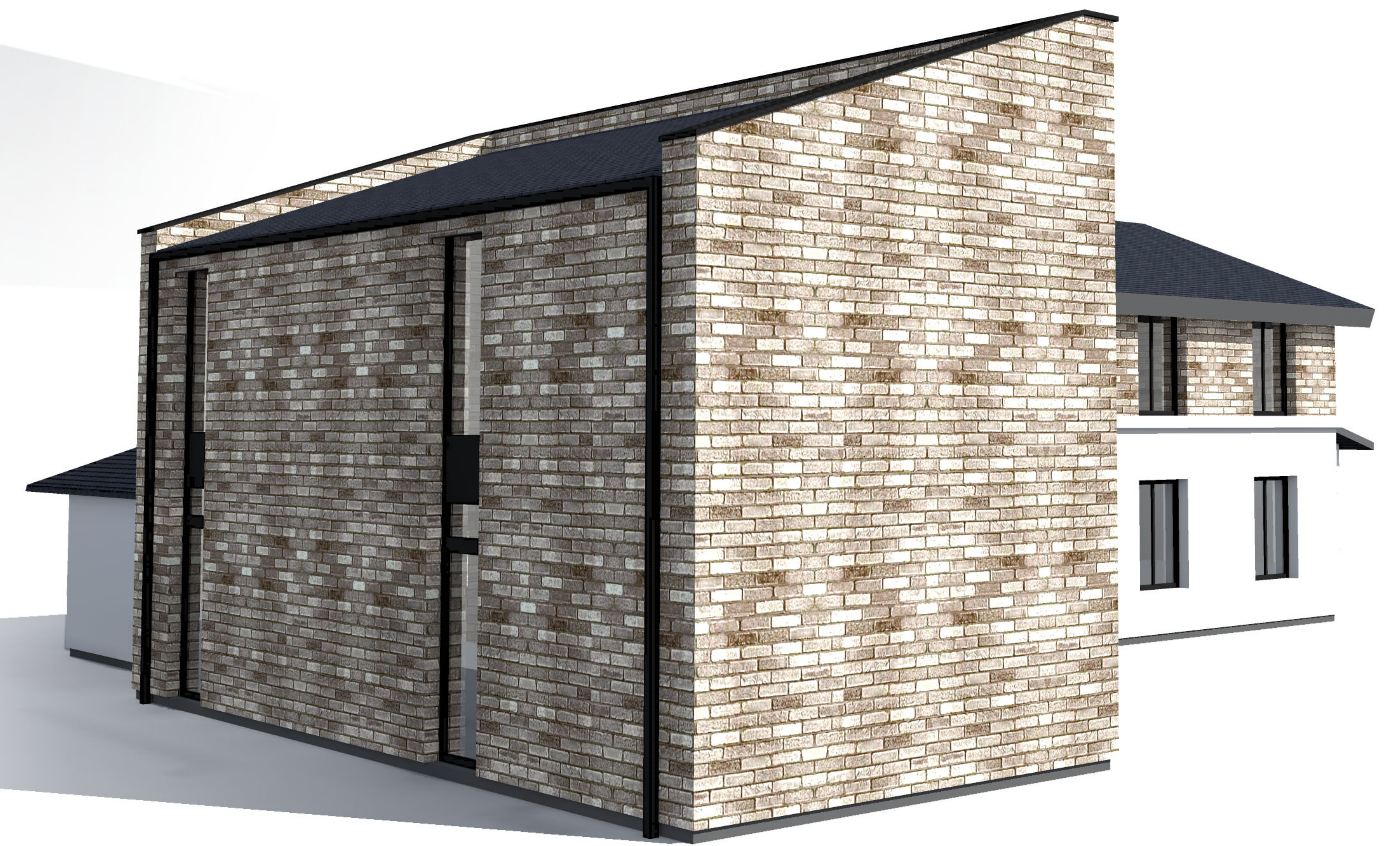
ŠIAURĖS - VAKARŲ FASADAS
