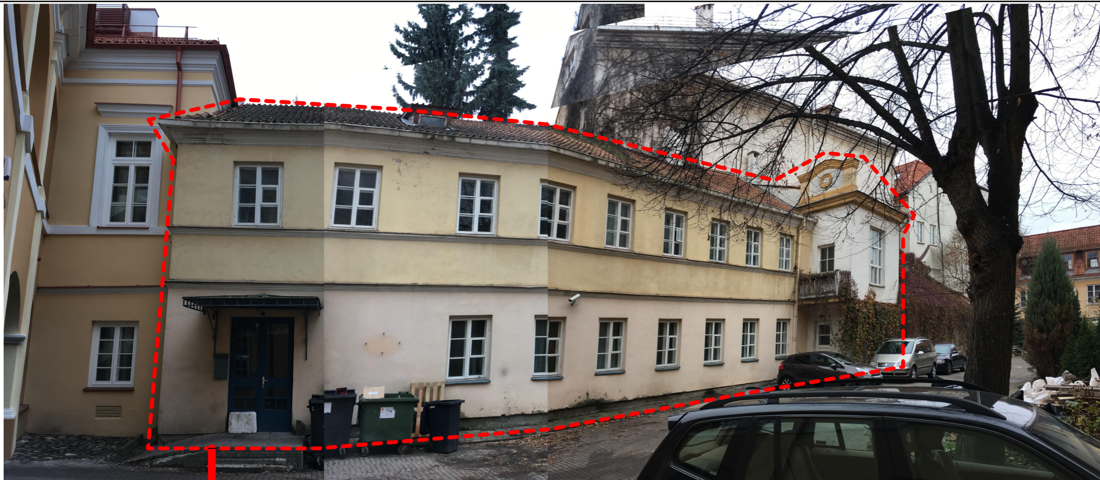
Remontuojama pastato dalis
