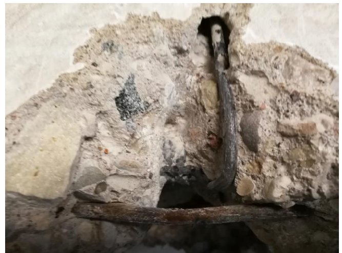
8 pav. Atidengta denginio plokštės armatūra.
