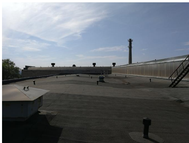
13 pav. Bendras pastato 28P1p stogo vaizdas.
