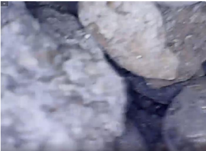
9 pav. Pastato 28P1p denginio tyrimas endoskopu. Denginys apšiltintas keramzitu.
