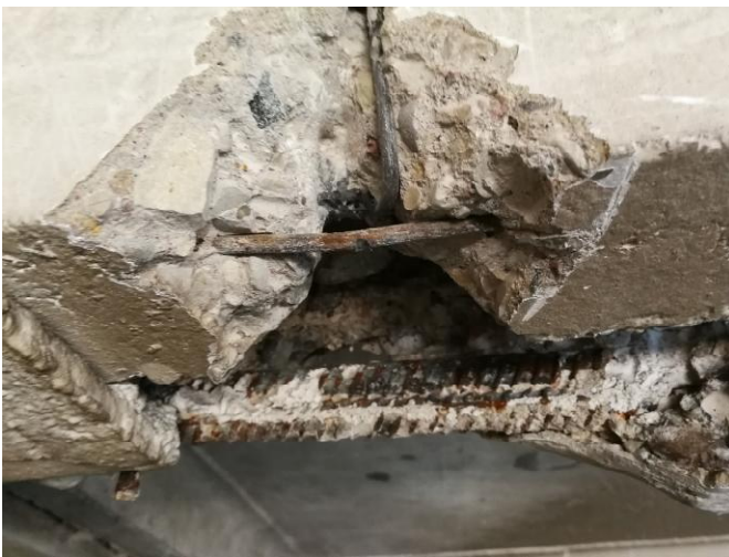
7 pav. Atidengta denginio plokštės armatūra.
