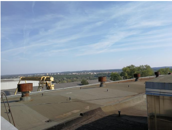
1 pav. Stogas ant kurio planuojama įrengti saulės elektrinės modulių.
