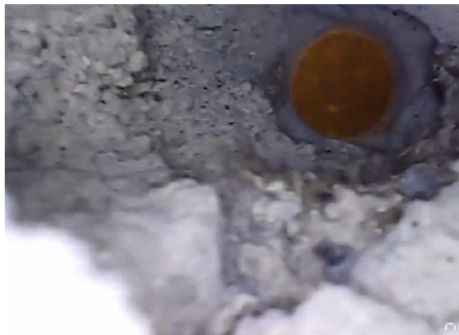
15 pav. Pastato 27P1p denginio tyrimas endoskopu. Matomas smėlis.
