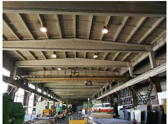
2 pav. Tiriama pastato 28P1p vidaus patalpų bendras vaizdas.
