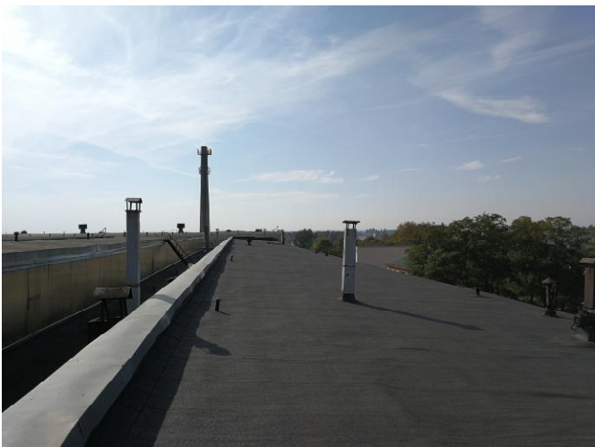
14 pav. Pastato 27P1p stogas.
