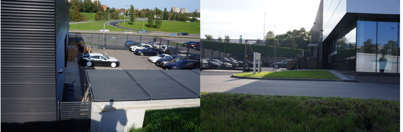
Pav. 10 Esamo serviso kiemo vaizdas
