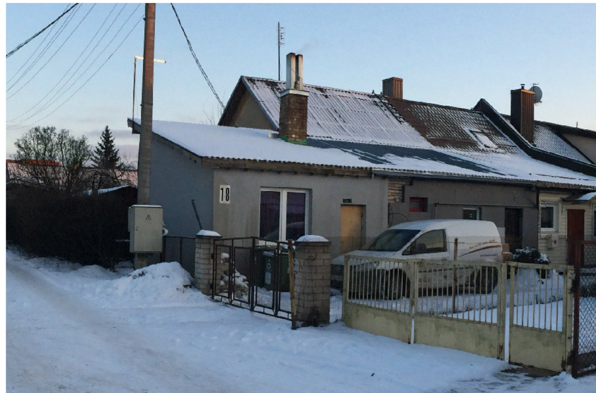
šiaurinė gyvenamojo namo pusė (nerekonstruojama)
