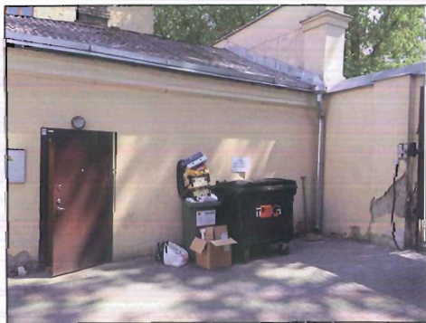
ESAMOS SITUACIJOS FOTOFIKSACIJA, 2016 FOTOFIKSACIJOS VIETA NR. 1
