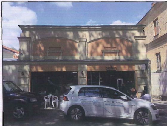
ESAMOS SITUACIJOS FOTOFIKSACIJA FOTOFIKSACIJOS VIETA NR. 5
