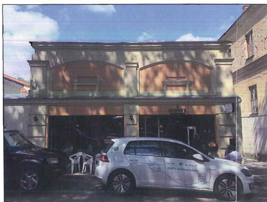
ESAMOS SITUACIJOS FOTOFIKSACIJA FOTOFIKSACIJOS VIETA NR. 5
