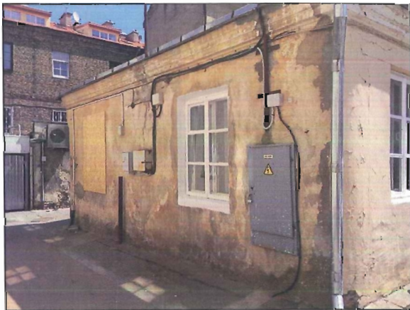
ESAMOS SITUACIJOS FOTOFIKSACIJA FOTOFIKSACIJOS VIETA NR. 6
