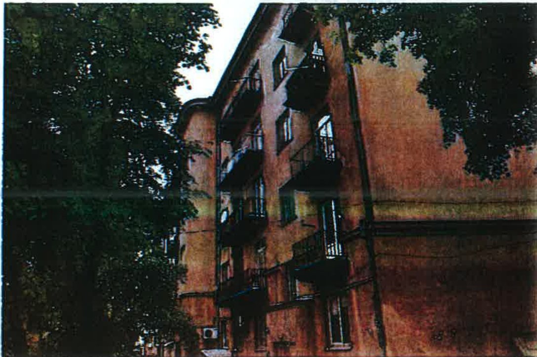
9 pav. Pastato sienoje iš vidinio kiemo pusės įrengti balkonai
