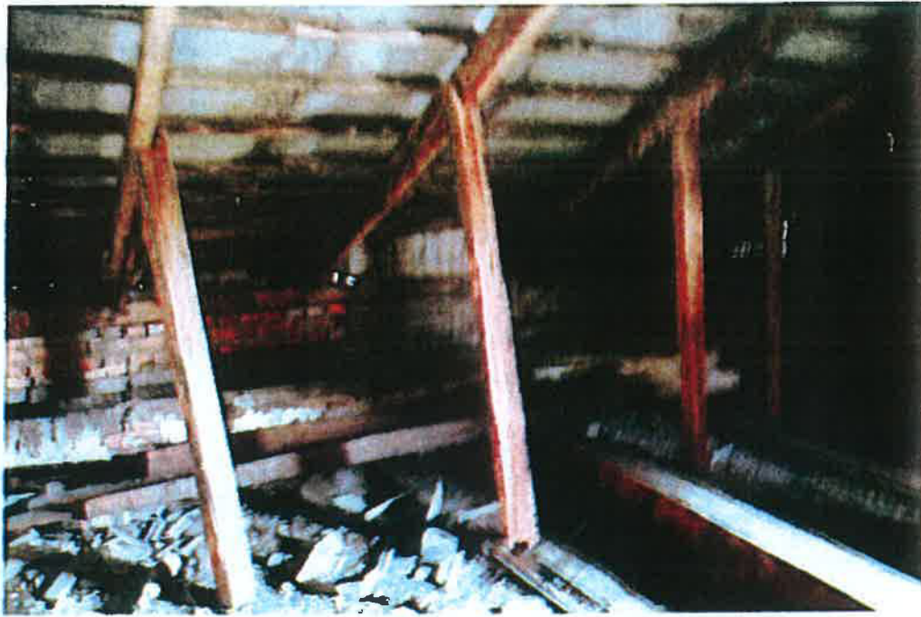
10 pav. Pažeistų gegnių parėmimas statramsčiais
