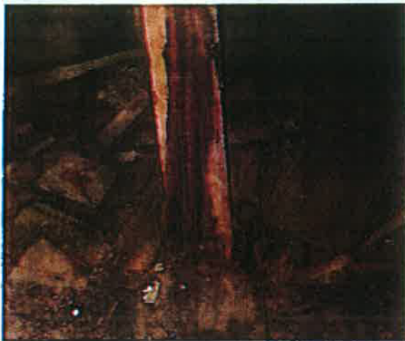
10 pav. Pažeistų gegnių parėmimas statramsčiais
