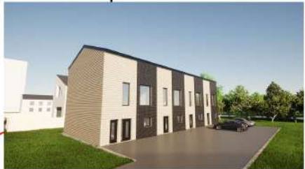
PROJEKTUOJAMI GYVENAMIEJI NAMAI DEIMĖS G. 10
