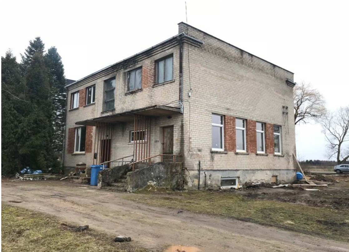
ŠIAURĖS RYTŲ PUSĖS FASADAI
