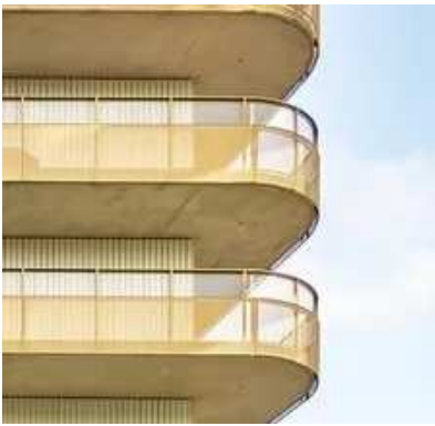
Balkono apdailos pavyzdys
