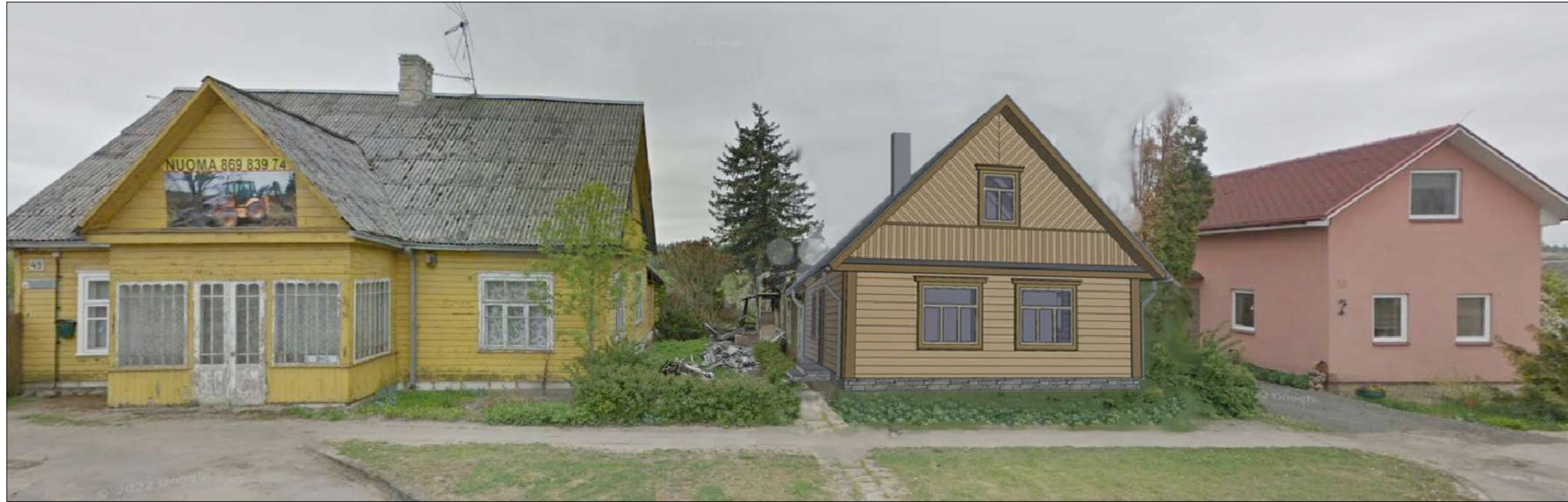
Fotofiksacija po rekonstrukcijos
