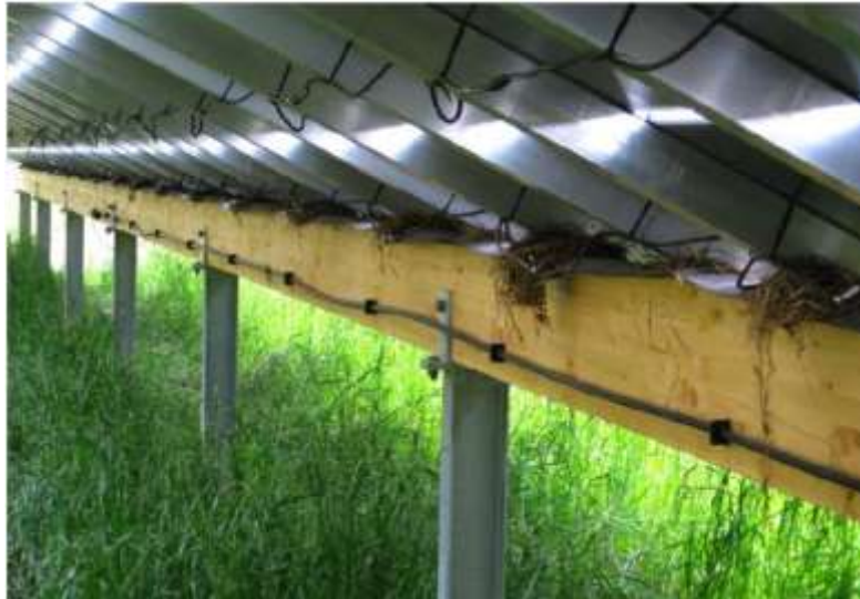
Pav. 24. Paukščių lizdai ant modulių atramos (Nuotrauka: BELECTRIC (Tarptautinis rekonstrukcijos ir plėtros bankas / Pasaulio bankas, 2018))
