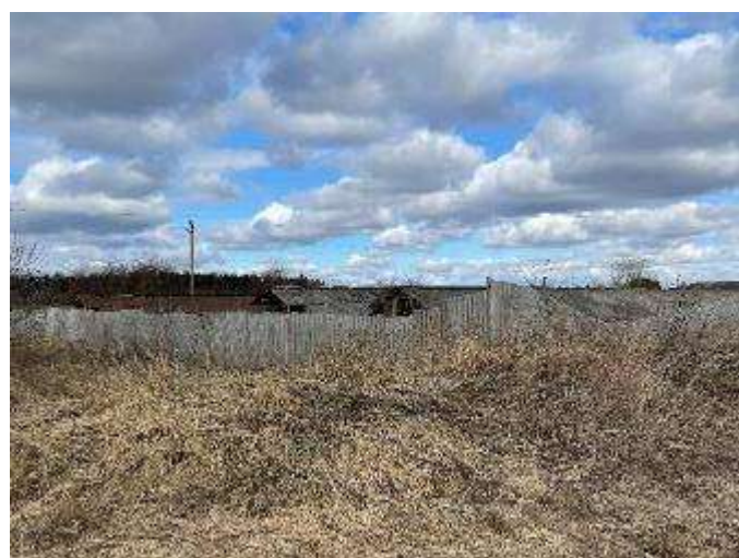
Vakarų pusėje apleisti žemės ūkio pastatai
