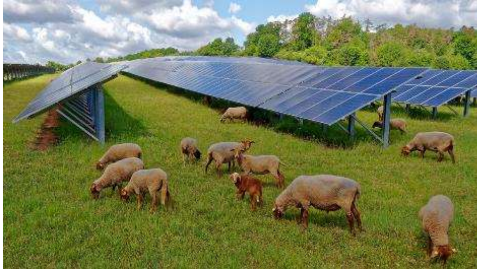
Pav. 8. Saulės elektrinių parko įrengimo pvz.
