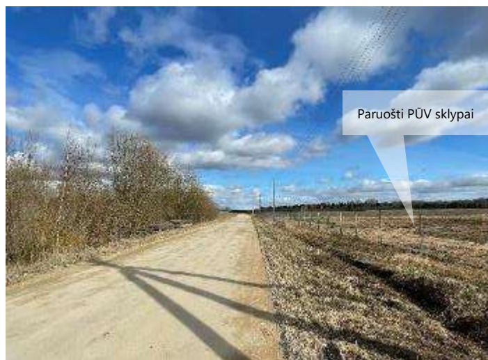
Kelias, OL ir vakarų pusėje apleistų žemės ūkio pastatų sklypas
