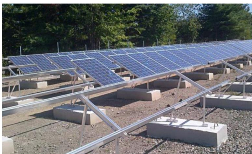
2.2.2. pav. Betoninio ir metalinio sraigtnio polių, o taip pat surenkamojo betono balasto sistemų iliustracijos (Šaltinis: https://ec.europa.eu/environment/nature/natura2000/management/docs/POTENTIAL%20IMPACTS%20OF%20SOLAR_%20GEOTHERM )
