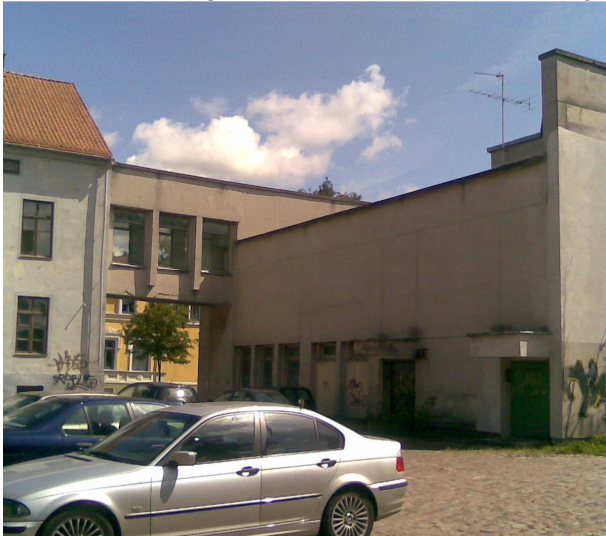
Pastato Sukilėlių g.14 bendras vaizdas iš šiaurės vakarų pusės.
