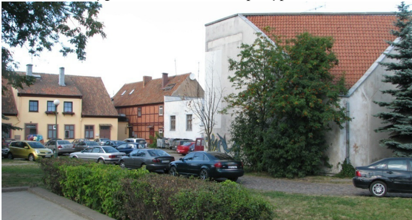
Pastato Sukilėlių g.14 bendras vaizdas nuo Pilies g. pusės.
