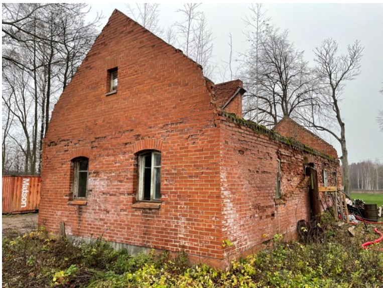
vaizdas iš šiaurės rytų pusės
