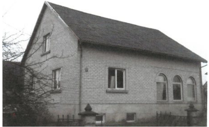
ŠIAURINIS IR RYTINIS FASADAI
