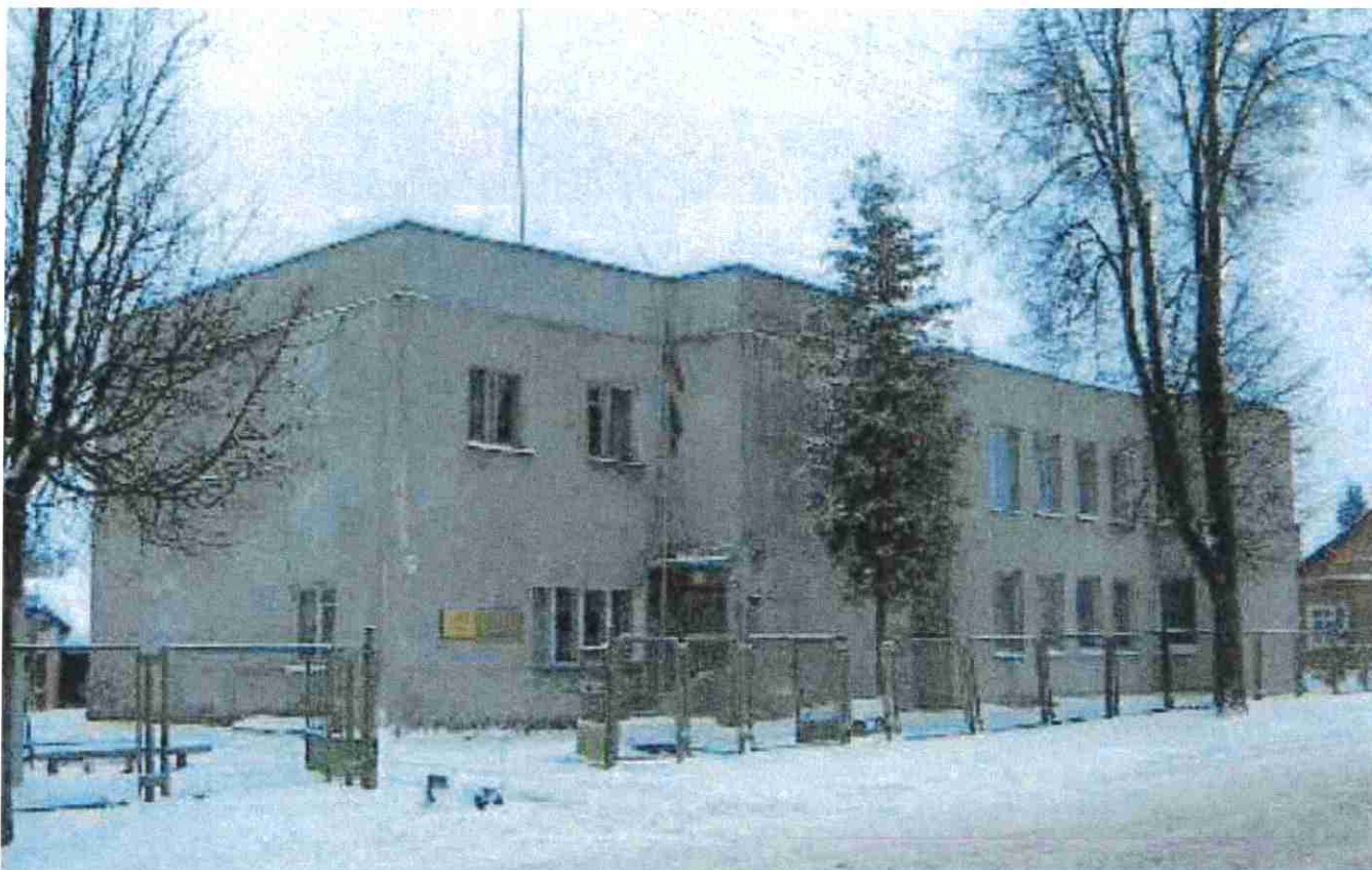
3 pav. Administracinis pastatas nuo Gedimino gatvės.
