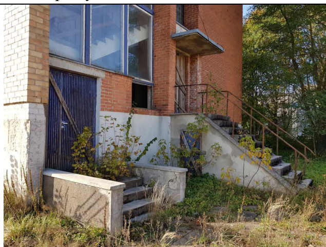
Pastato rytinis fasadas.
