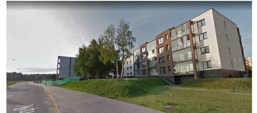
4. BAJORŲ K. 6 SKLYPE ESANTIS KOMERCINĖS PASKIRTIES PASTATAS
