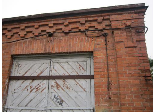
05-03. Pleištinė sąrama ir pastogės karnizas
