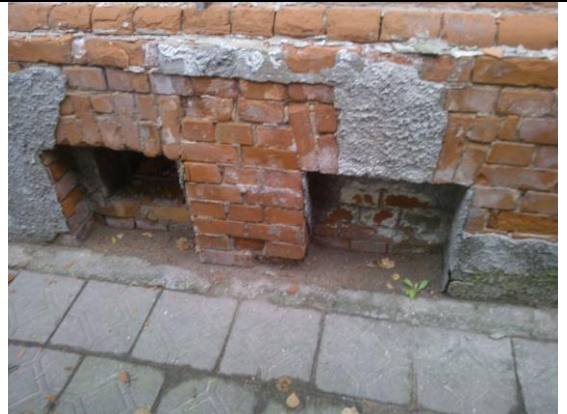
01-26. Cokolinės dalies Kranto g. fragmentas
