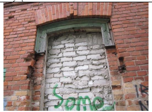
06-04. Pleištinė sąrama su stakta
