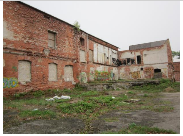
01-6. Rytų (kiemo) fasado centrinės dalies fragmentas
