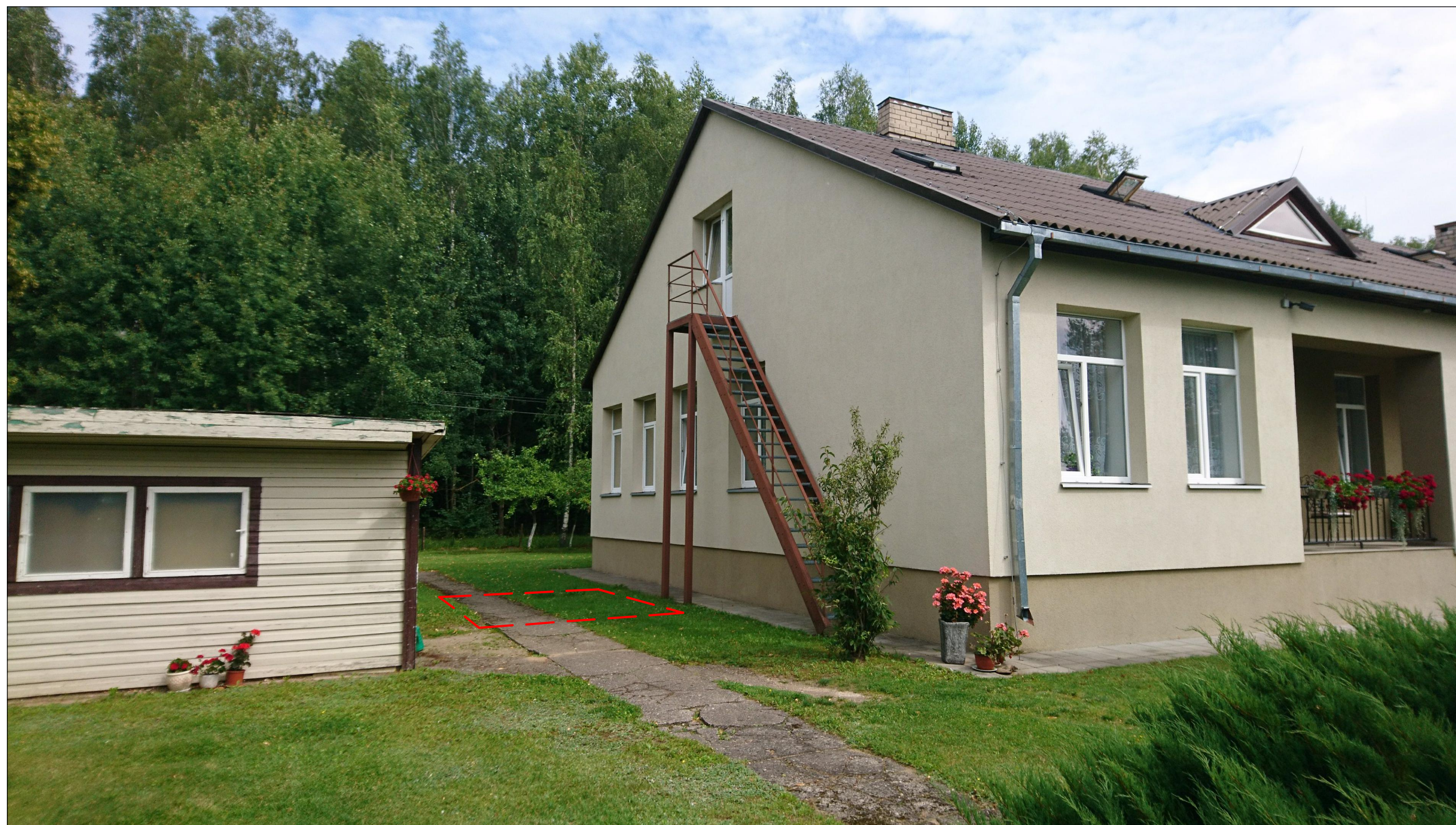
Pastatas prieš remontą su planuojama lifto vieta
