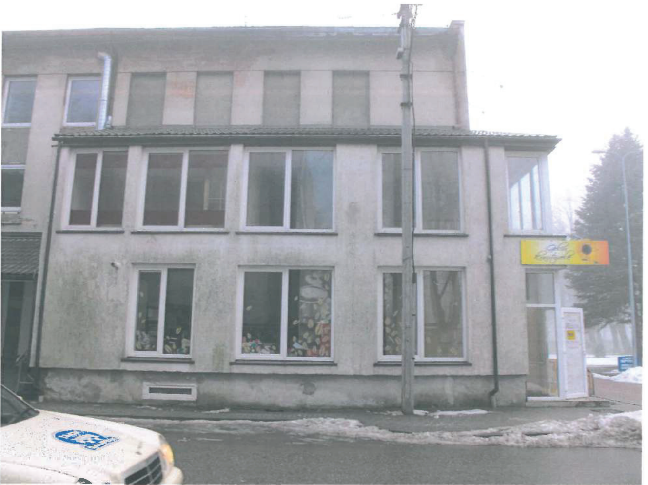
Rotušės a. 1, Kretingoje pastato fotografacija 2
