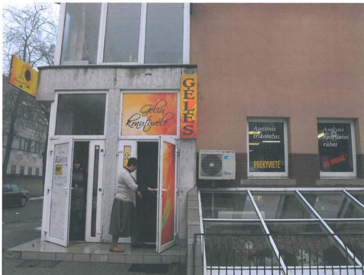
Rotušės a. 1, Kretingoje pastato fotografacija 1
