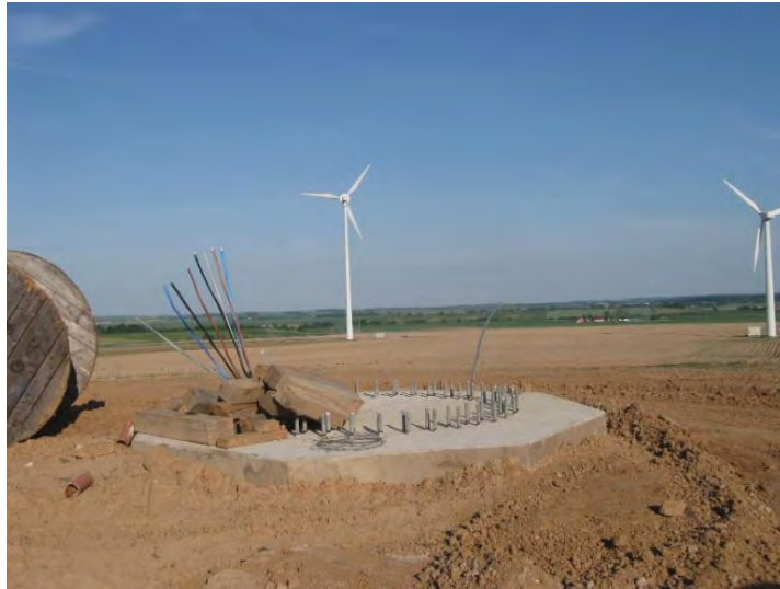
5.4 pav. VJ pamatas, statant plieninį stiebą
