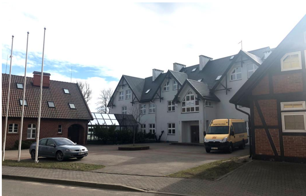
pastato vaizdas nuo šiaurinės pusės
