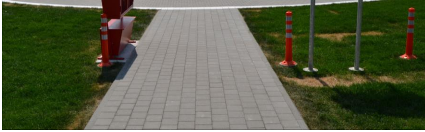
Betoninės trinkelės (100 x 100).
