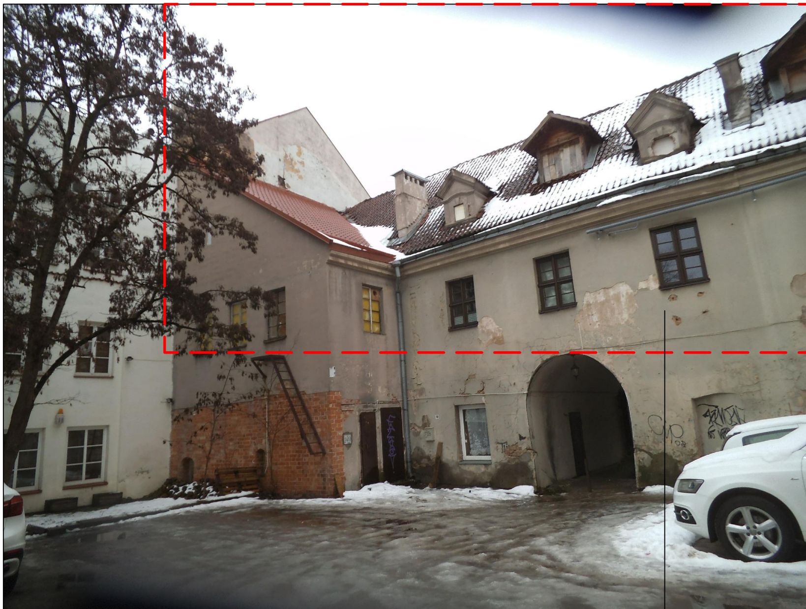
Pastato Didžioji g. 27, Vilniuje, kiemo fasadas remonto vieta
