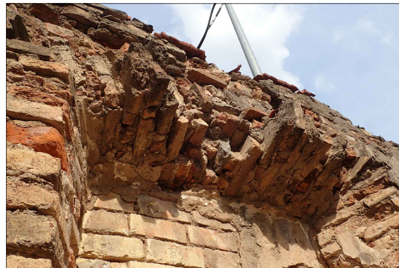
Lango angos segmentinė sąrama
