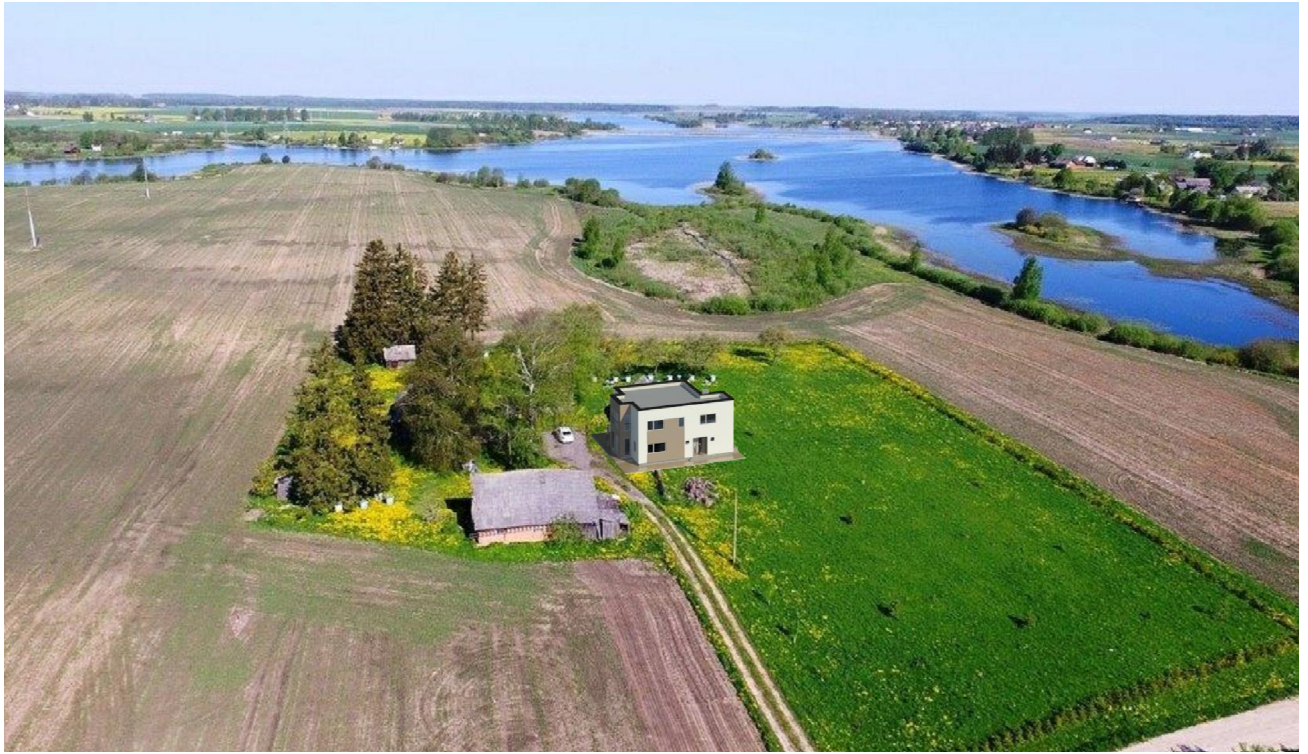
5 pav. VAIZDAS PO PASTATO REKONSTRAVIMO
