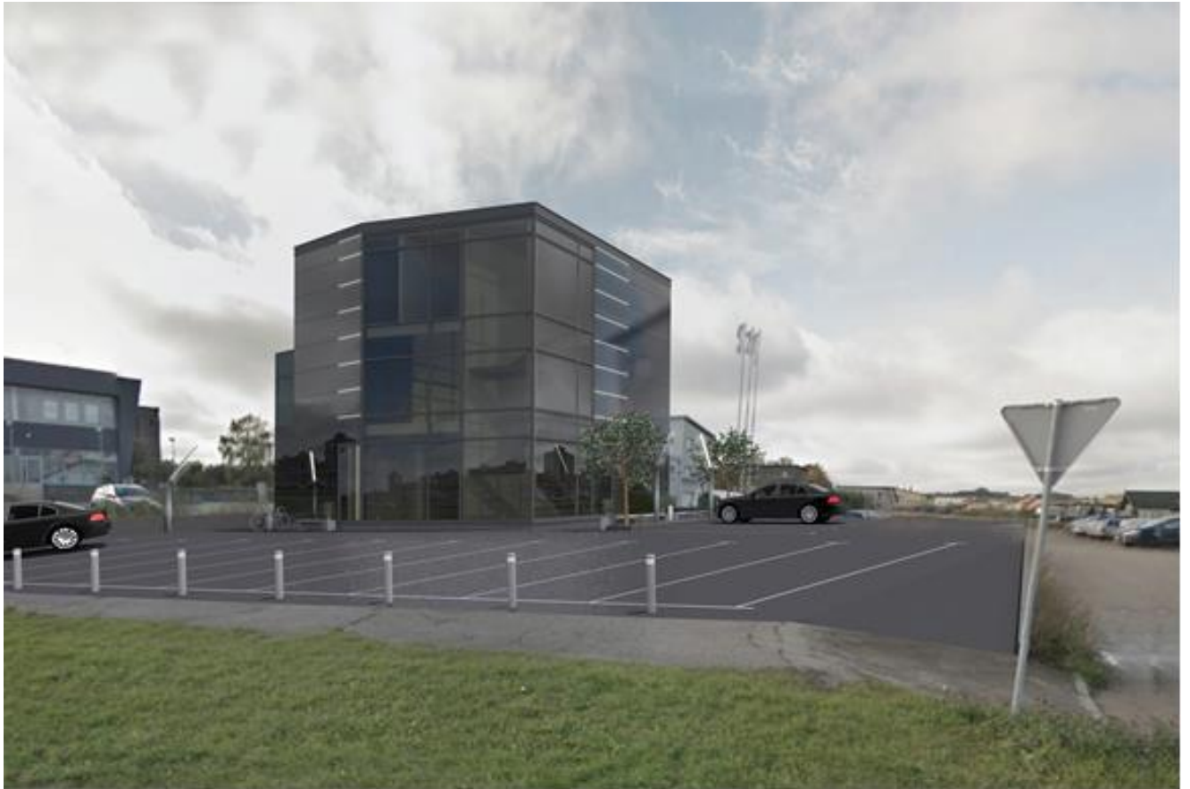
Administracinis pastatas (iš šiaurės vakarų pusės)
