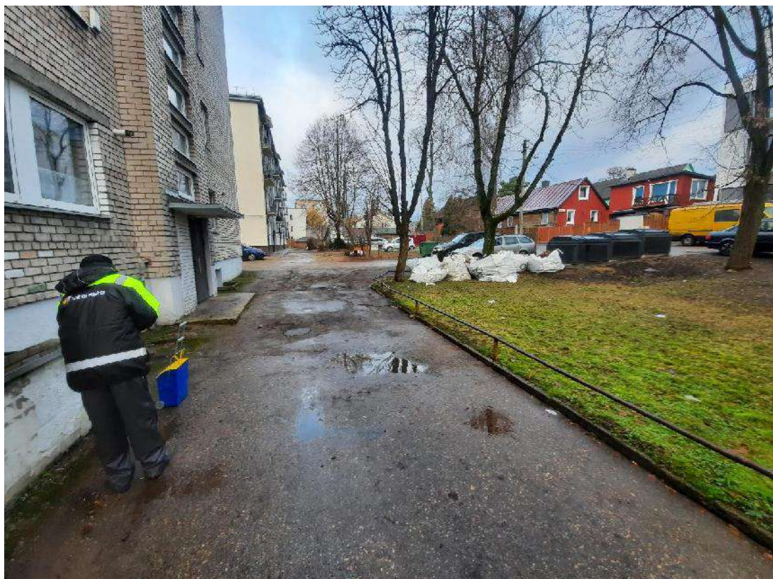
3 pav. Esamos situacijos fotofiksacija
