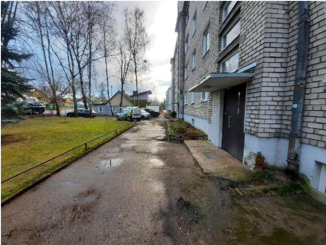
2 pav. Esamos situacijos fotofiksacija
