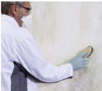
pav. 3 Paviršiaus valymas
