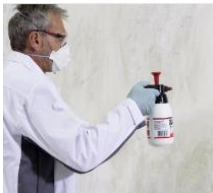
pav. 2 FungoFluid purškimas
