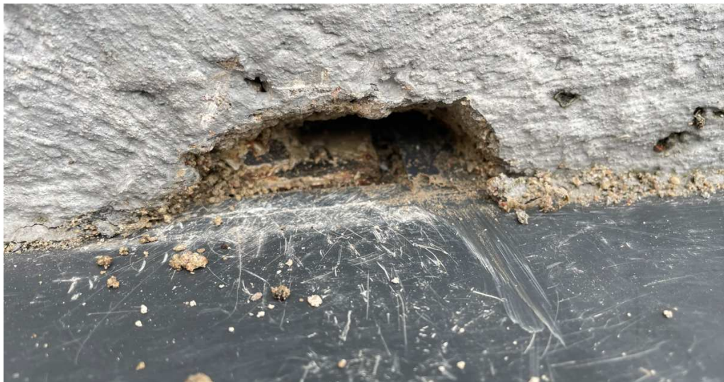
6 pav. Ardymo metu paaiškėjo: statybos metu plieninė nuolaja ties balkonų plieno statramsčiais yra iškarpyta, o hidroizoliacija neužleista ant skardos ir apie statramstį.
