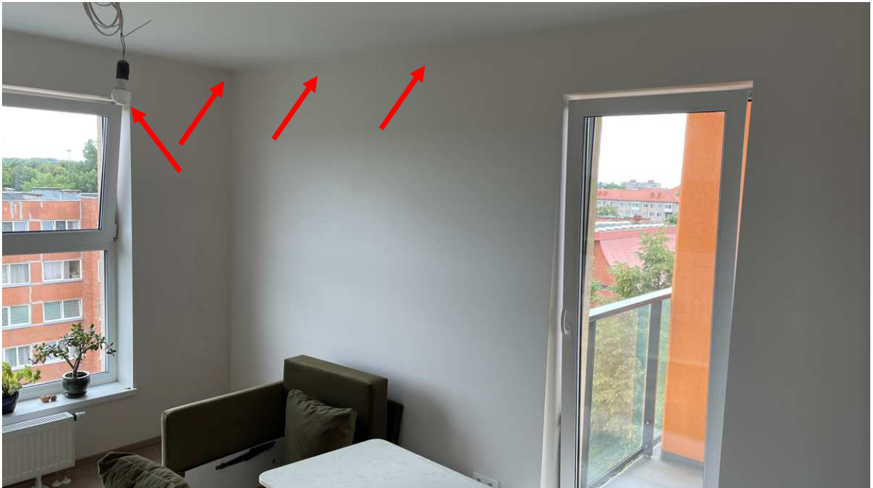
3 pav. Butas Nr. 55 patalpos Nr. 55-2 (2 priedas) viduje vandeniui apšlamštinamoms sienoms vaizdas
