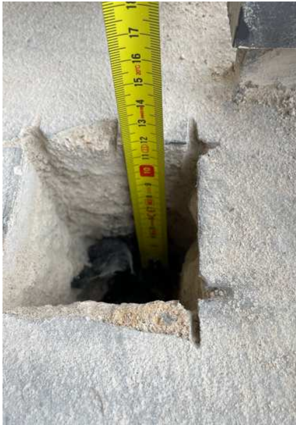
9 pav. Bute Nr. 55 balkono plokštės atidengtų sluoksnių (3 priedas) vaizdas
