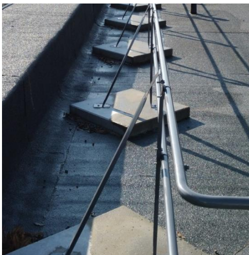
Principinis tvorelės įrengimo variantas, nepažeidžiant stogo dangos.
