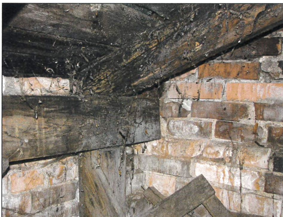
NEĮRENGTOS PASTOGĖS VAIZDAS SU GEGNĖMIS IR ILGINIU (MURLOČIU), KURĮ LAIKO STATRAMSTIS PAREMTAS ANT PERDENGIMO SIJOS
