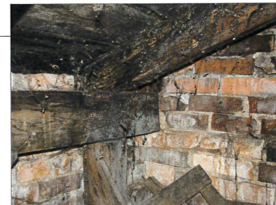
KRAŠTINĖ GEGNĖ - SUPUVUSI, KEISTI NAUJA.
