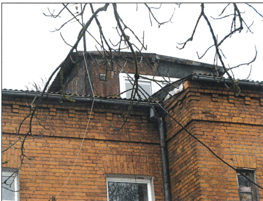
ESAMAS STOGO VAINIKUOJANTIS KARNIZAS IŠ PRAKIŠTŲ RAUDONŲ MOLIO PLYTŲ
