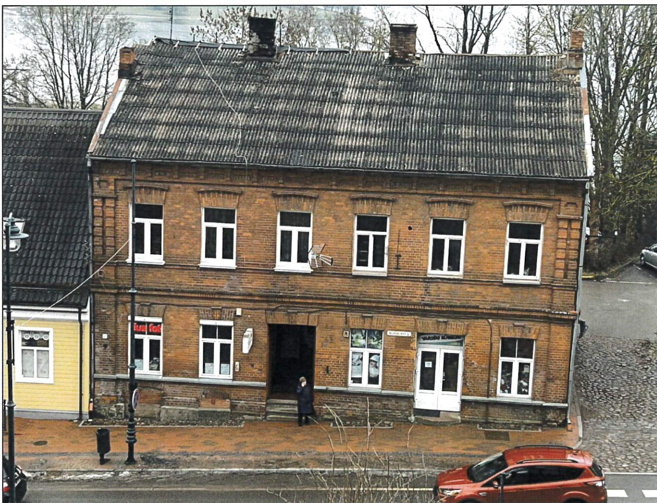
PAGRINDINIO ŠV (RESPUBLIKOS G.) FASADO IR STOGO VAIZDAS . STOGAS DENGTAŠ ŠIFERIU, KURIO BŪKLĖ BLOGA
