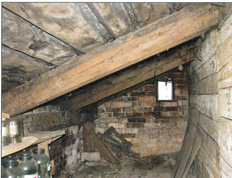
NEĮRENGTOS PASTOGĖS VAIZDAS SU GEGNĖMIS IR ILGINIU (MURLOČIU)
