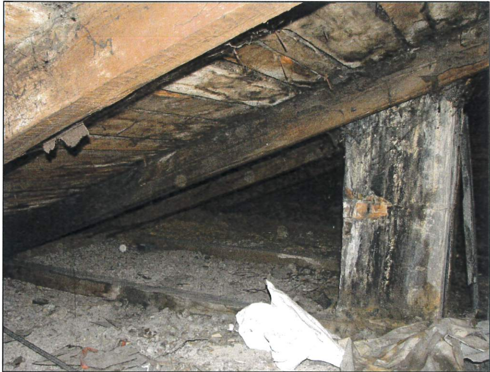
PASTOGĖJE KAMINAI – TINKUOTI. TIES KIEKVIENA GEGNE MATOSI STYGOS.
