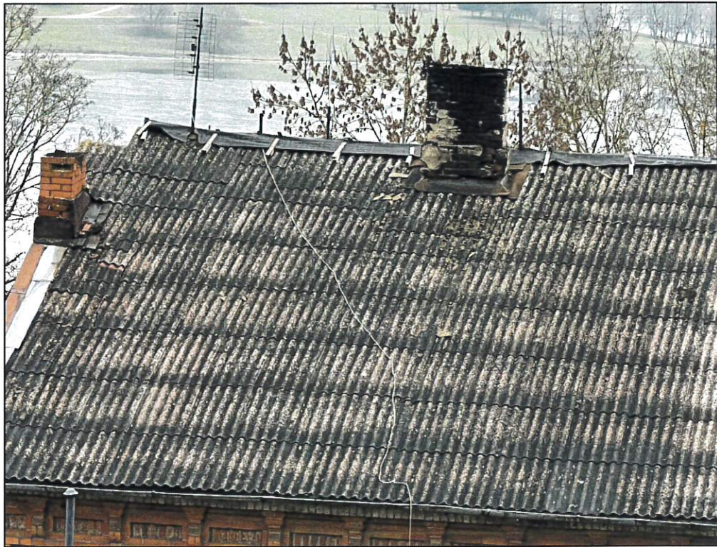
PAGRINDINIO FASADO STOGO VAIZDAS SU KAMINAIŠ. STOGO BŪKLĖ – BLOGA. KAMINŲ BŪKLĖ TAIP PAT BLOGA. PLYTOS VIETOMIS IŠKRITUSIOS, VIETOMIS MŪRYTA SILIKATINĖMIS PLYTOMIS
