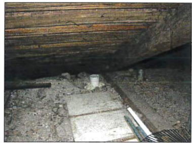
Vaizdas pastogėje. Po kiekviena gegne - styga, tarp kurių užpildas iš šlako šlako
