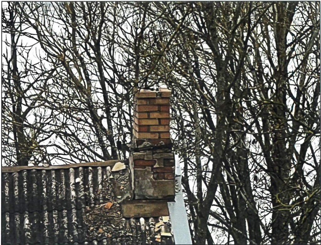
PV GALINIO FASADO KAMINO SIŪLĒS IŠTRUPĒJUSIOS, KAI KURIOS PLYTOS - PAKEISTOS
