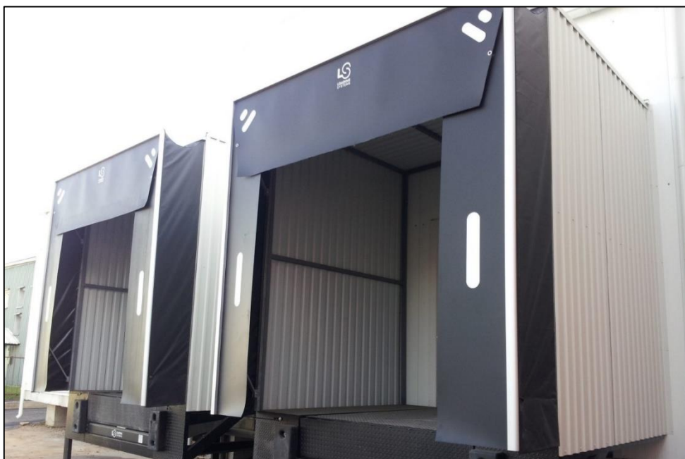
Pav. 4. Rampa su sandarinimo rankove
