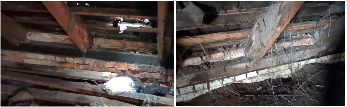
6.pav. stogo laikančios konstrukcijos, mūrtašiai.
