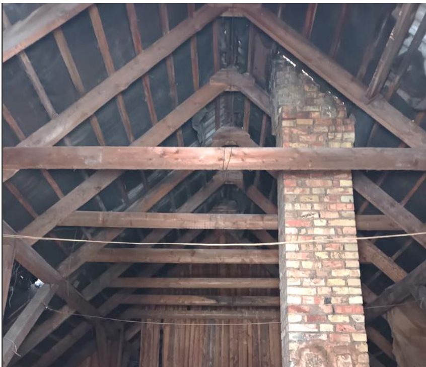
4.pav. stogo laikančios konstrukcijos, gegnės ir stygos.
