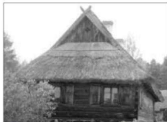
Pirkios iš Zervynų k. Varėnos r. Čiukurinio ir dvišlaičio stogo formų derinys (jos brėžiniai pateikti 16 psl.) [LLBM]
